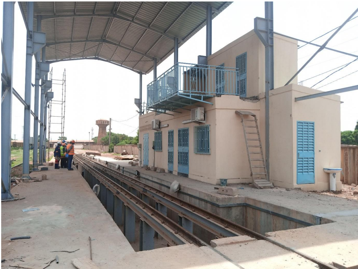
L'ATS de Bobo Dioulasso, réalisé à plus de 400 millions de FCFA, vu de l'intérieur pendant travaux
