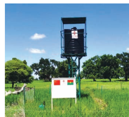
2019 : Un puits solaire construit à Naliou est devenu une source complémentaire d'irrigation.
